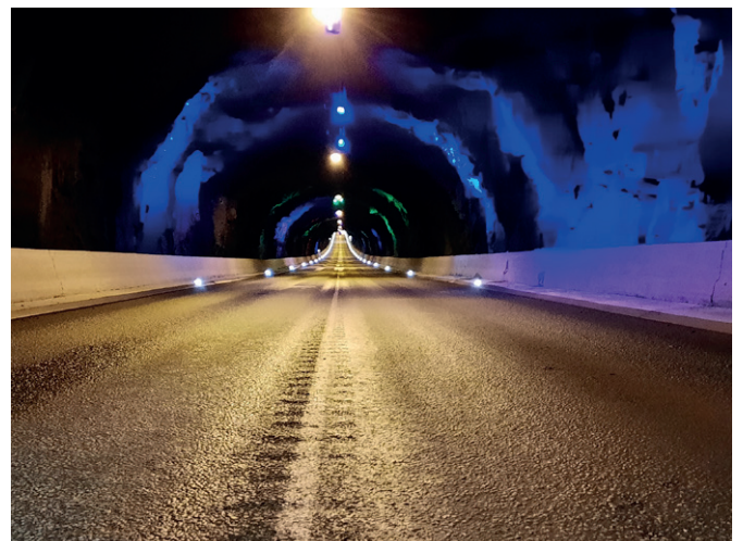
Tunnelbeleuchtung Nordoyatunnel Färöer
