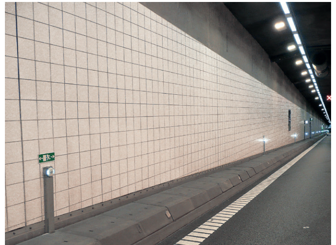
Tunnel Limfjord Dänemark
