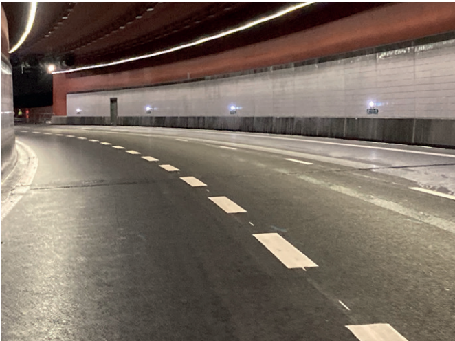
Mariefholmstunnel Göteborg Schweden
